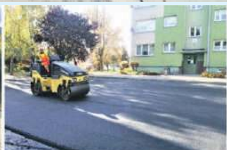
Rozpoczął się drugi etap remontu ulicy Kamiennej
