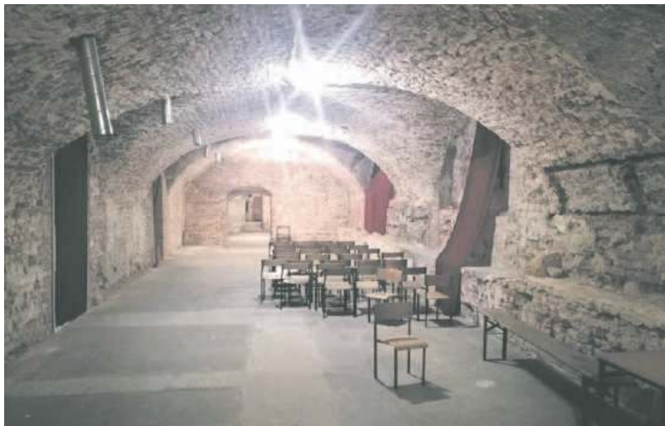
W tej największej piwnicy zaplanowano salę widowiskową
