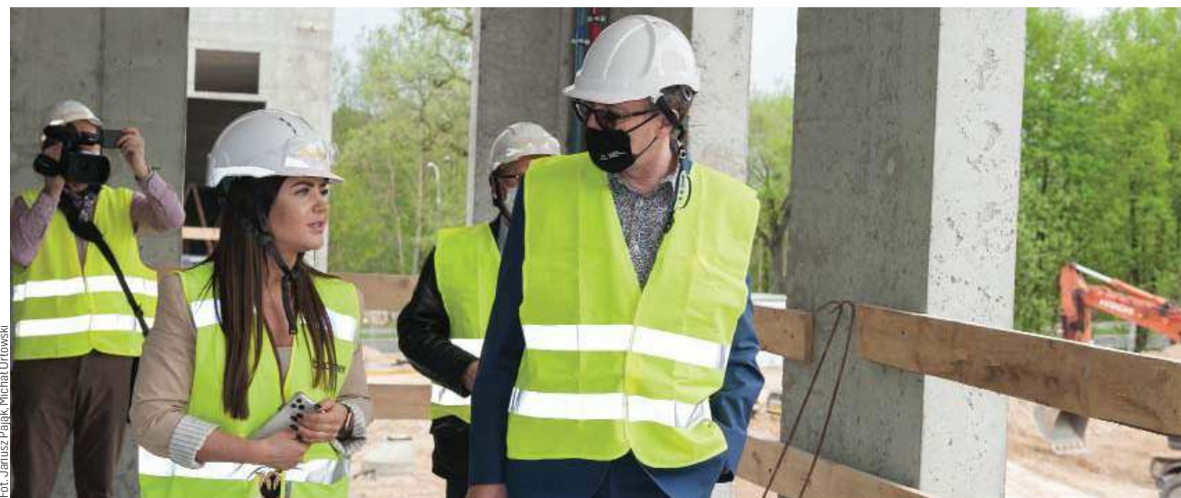
Rectora UWM prof. Jerzego Przyborowskiego oprowadzała Klaudia Breńska, kierowniczka budowy
