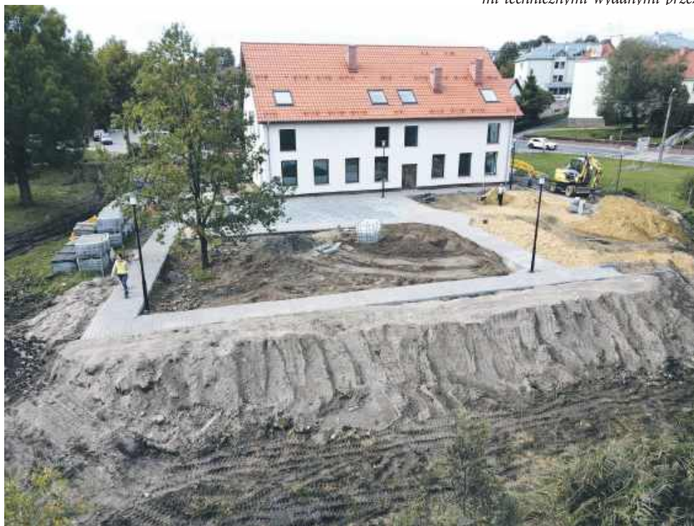
Podobnie jest z drugiej strony dachu. Widać też, jaka skarpa została usypana i ile jeszcze pracy jest do wykonania
