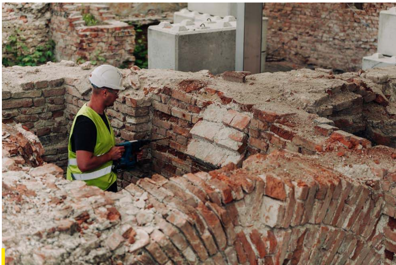
Prace geodezyjne, fot. T. Tołłoczko / Pałac Saski sp. z o.o.
