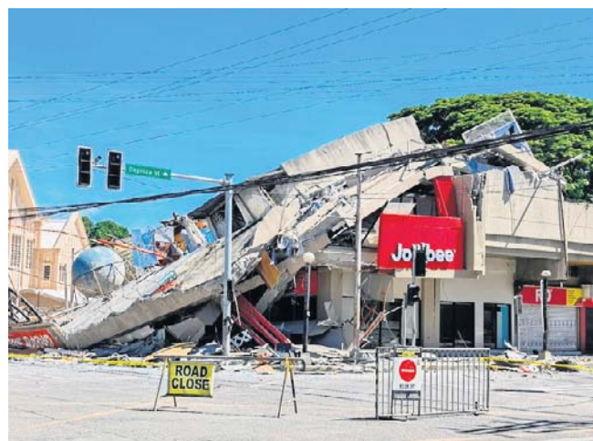
Trzęsienie ziemi nawiedziło południowe Filipiny. Uszkodzony budynek w General Santos
