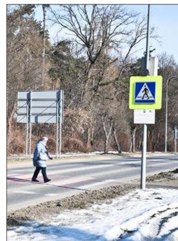
To aktywne przejście niewłaściwie funkcjonuje od początku.
