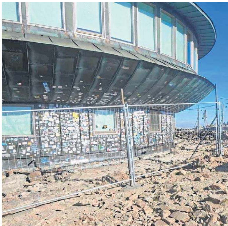
„Spodki” są już ogrodzone, ekipy zabezpieczają podłogi wewnątrz
