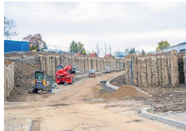
Budowa nowej drogi w Zakopanem, która połączy rondo im. Klimka Bachledy z dworcem autobusowym
