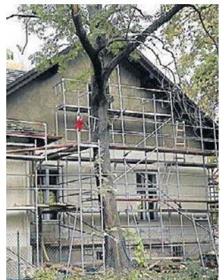
W Modrzejówce trwają jeszcze prace remontowe
