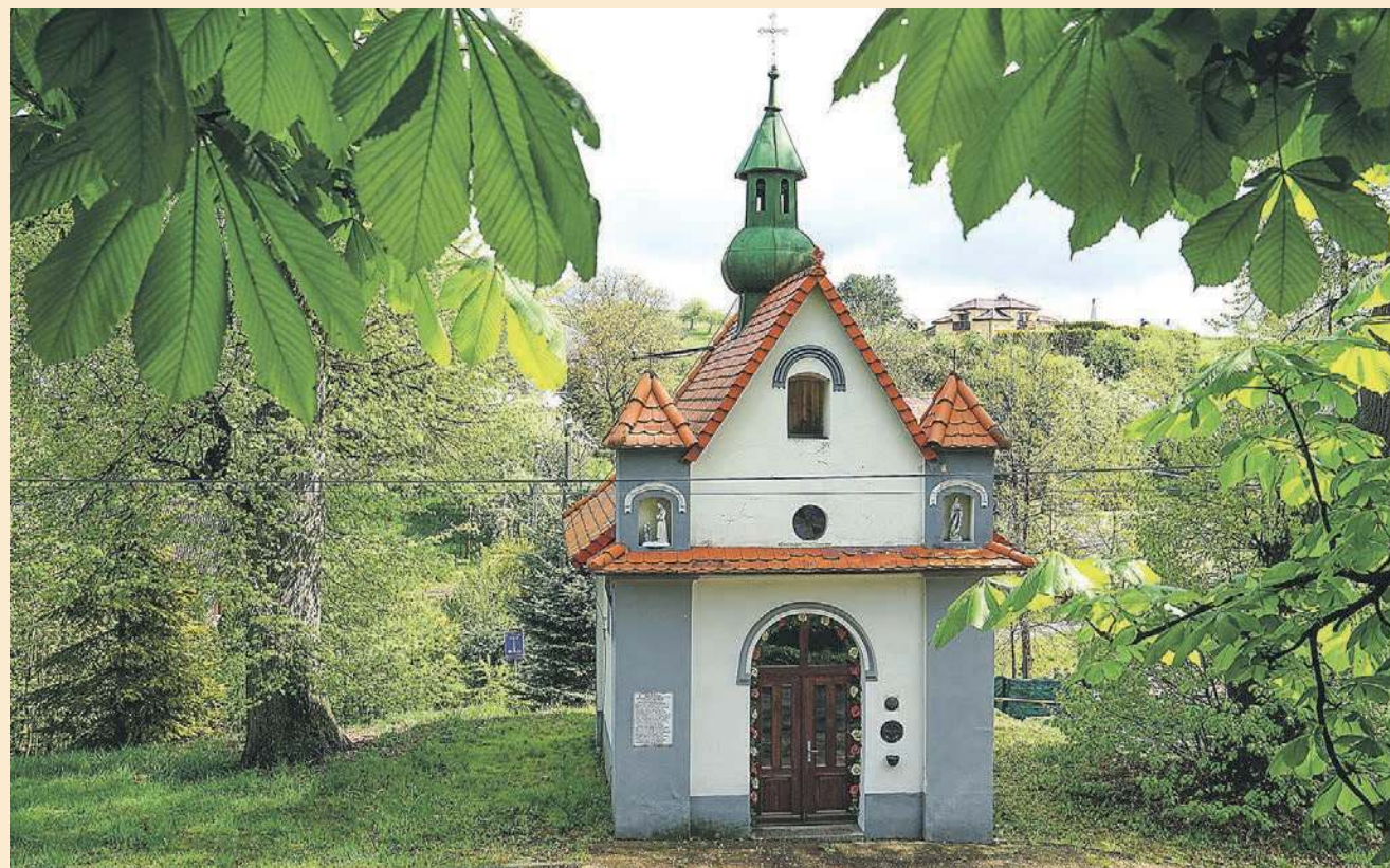
GROJEC. Kaplica pw. Niepokalanego Poczęcia Najświętszej Maryi Panny przy ul. Głowackiego (obok szkoły), wybudowana w latach 1855 - 1861
