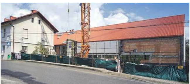
Budowana sala gimnastyczna przy szkole w Grojcu
