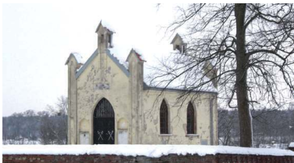
Parafia w Żyrzynie otrzymała od gminy w ubiegłym roku 30 tys. zł na wykonanie prac konserwatorskich Kaplicy Grobowej Wesslów, którą utworzono w latach 1853 i 1854 r. W ramach remontu usunięto np. kraty w oknach
