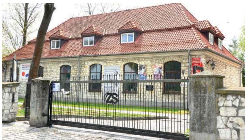
Na różne prace remontowe w ponad stuletnim Zespole Szkół im. J. Koszczyca-Witkiewicza powiat puławski zabezpieczył w tegorocznym budżecie 516 tys. zł. W pierwszej kolejności naprawiona zostanie elewacja budynków od strony ul. Nadwiślańskiej
