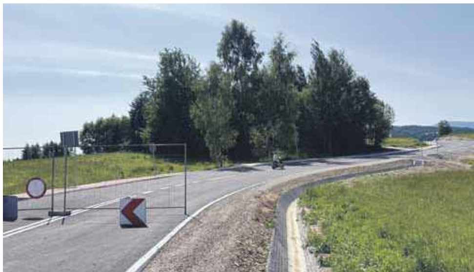
Piękny asfalt w miejscu dotychczasowej drogi gruntowej.
