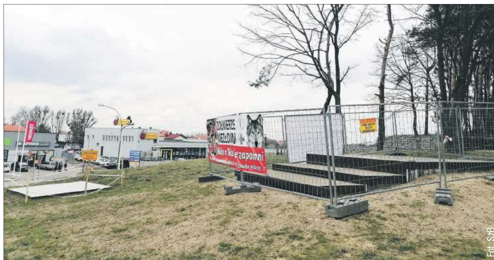
Fundament pomnika jest już postawiony. W niedzielę, 1 marca, wmurowano już tam symboliczny kamień węgielny.
