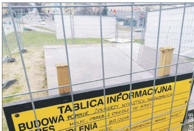
Fundament został wybudowany na froncie Góry Cyranowskiej.
