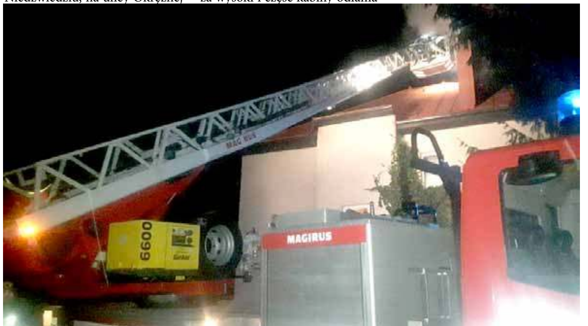
26 stycznia strażacy z OSP w Kobylance gasili pożar przewodu kominowego w miejscowości Niedźwiedź
