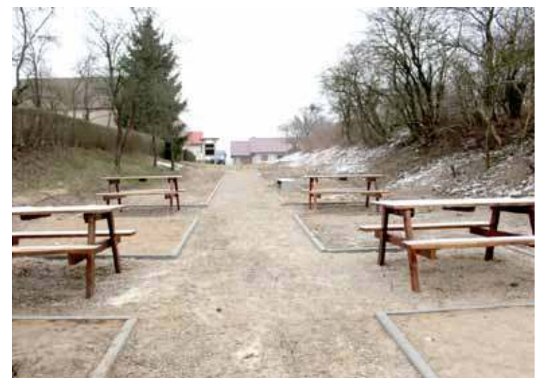
Zamontowano ławki oraz stoły piknikowe
