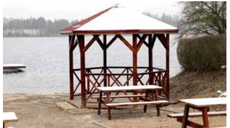
Postawiono również drewnianą altanę.
