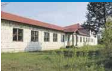
Budynek Zakładu Opiekuńczo-Leczniczego przed rewitalizacją
