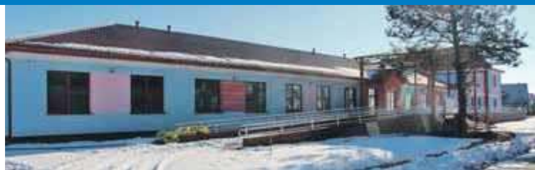
Budynek Zakładu Opiekuńczo – Leczniczego w Curyńcu w trakcie rewitalizacji
