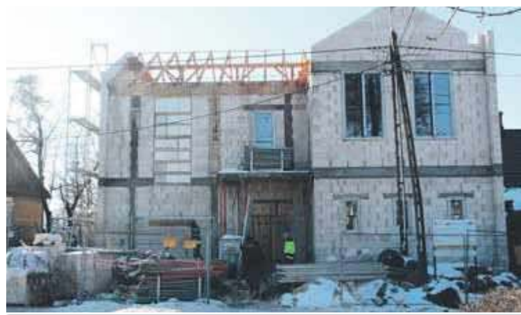
Budynek w centrum Wisznic w trakcie rewitalizacji
