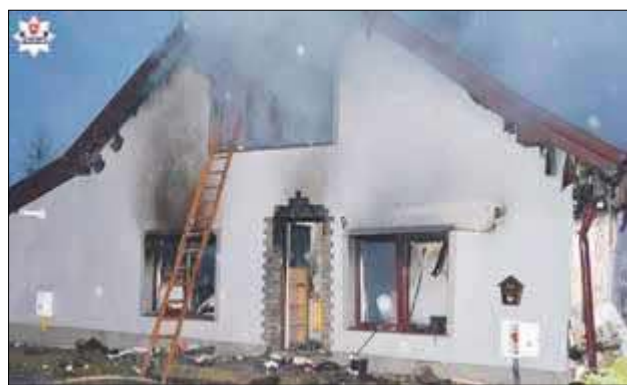
Siła wybuchu bardzo mocno uszkodziła dom
