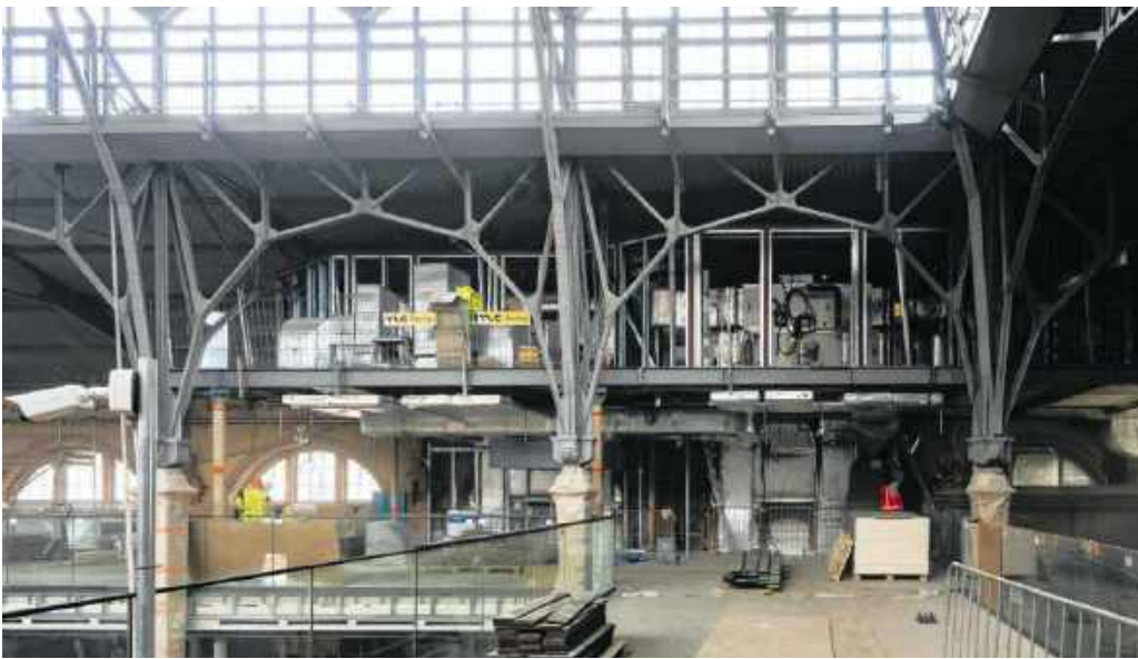
• Najemcy rozpoczęli już prace aranżacyjne i wykończeniowe FOT. DAWID LINKOWSKI
