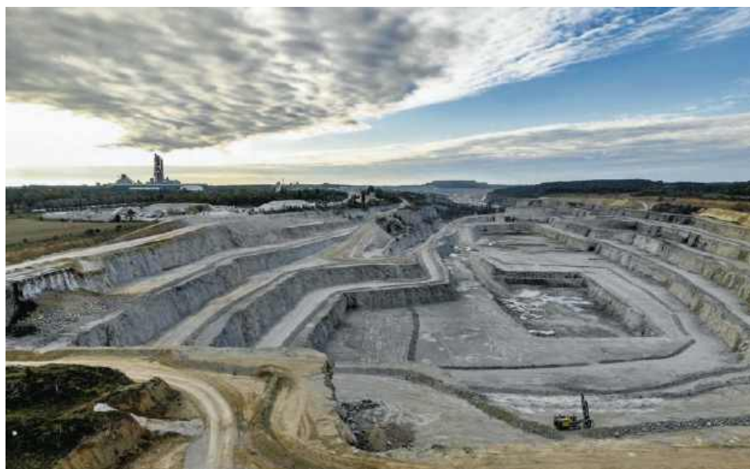
• Kopalnia wapienia w Piechcinie FOT. MACIEJ KULESZA
