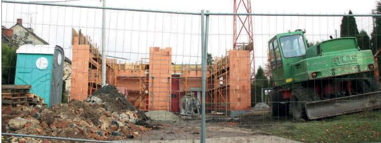
OSP Samborowice to obecnie plac budowy
