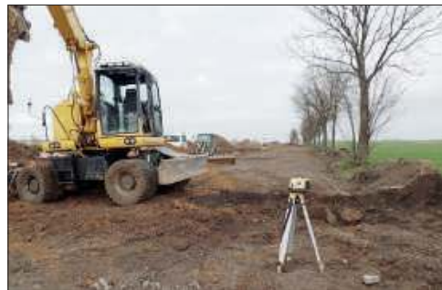
Przebudowa drogi powiatowej w Kornicach
