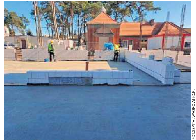
Wylano ławy fundamentowe, stanęły ściany.
