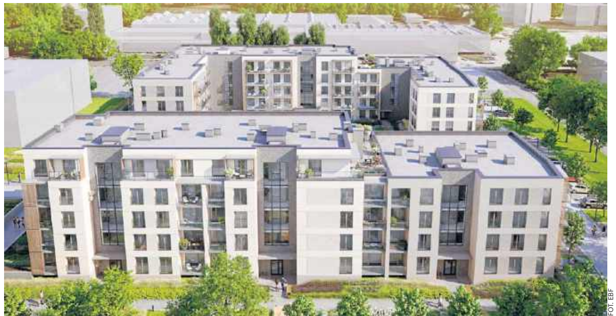
Grunwald Park jest już na ukończeniu. W dwóch wielorodzinnych budynkach można kupić mieszkanie liczące od jednego do czterech pokoi
