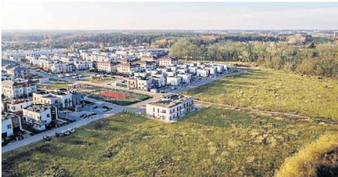
Osiedle Księżnej Dąbrowki - mieszkania na nim można wykończyć samodzielnie, według własnych pomysłów, albo skorzystać z projektu pracowni projektowej
