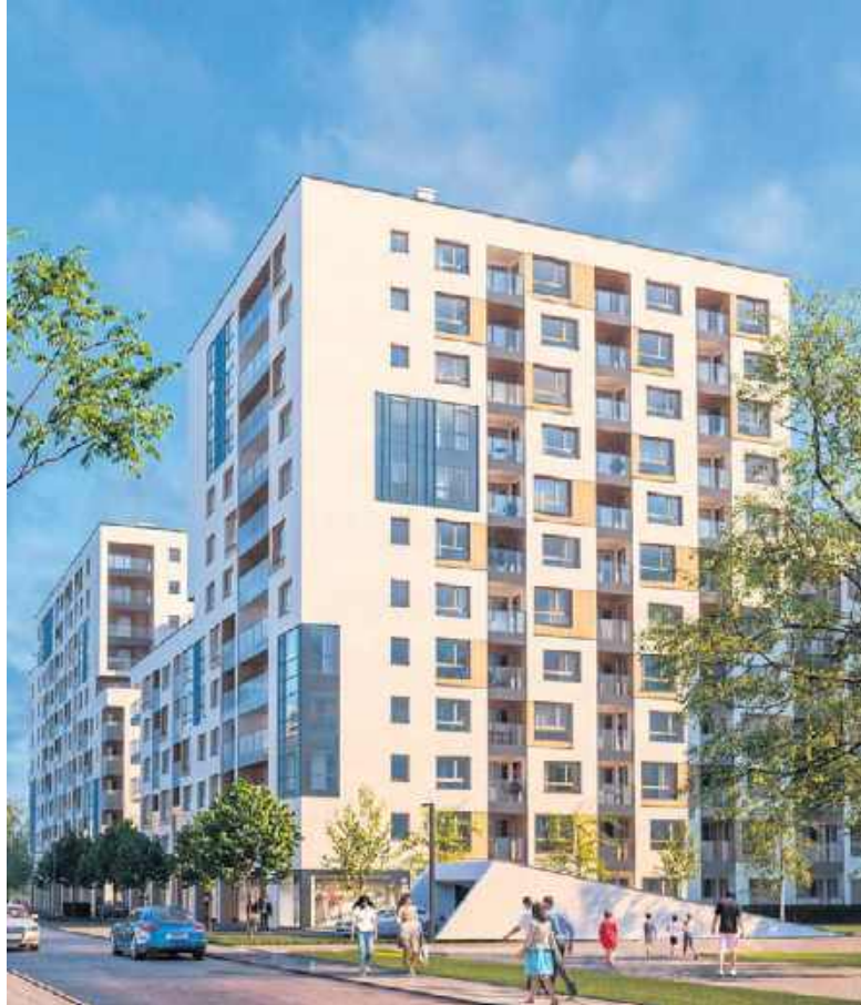
Wybrane mieszkania w kolejnym etapie osiedla budowanego przez firmę Ataner Świerzawska 13 z okazji 35-lecia istnienia firmy będzie można kupić ze zniżką 35 tysięcy złotych
