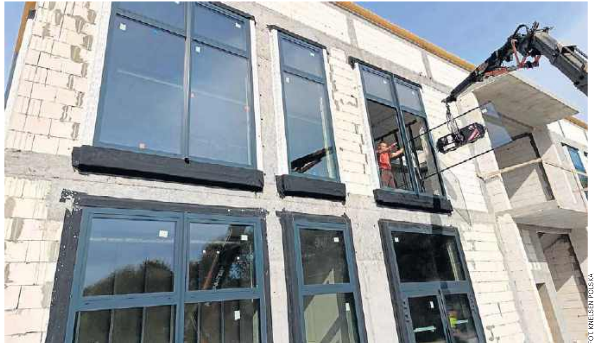
Nie wystarczy wymienić jednego okna: wszystkie muszą być szczelne i odpowiednio połączone ze ścianami
