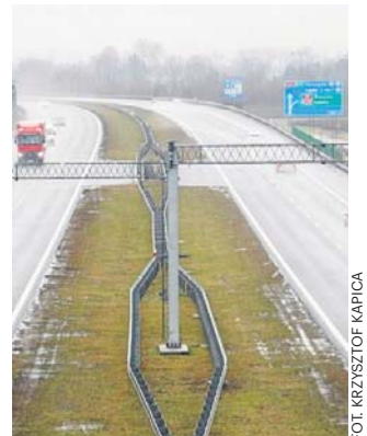
Remont potrwa do października
