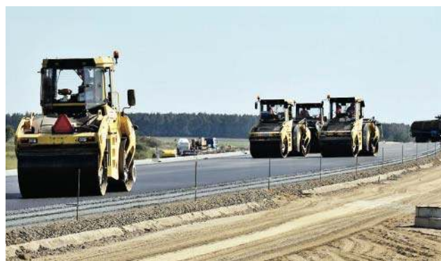
Budowa drogi S5 Ostróda — Nowe Marzy
