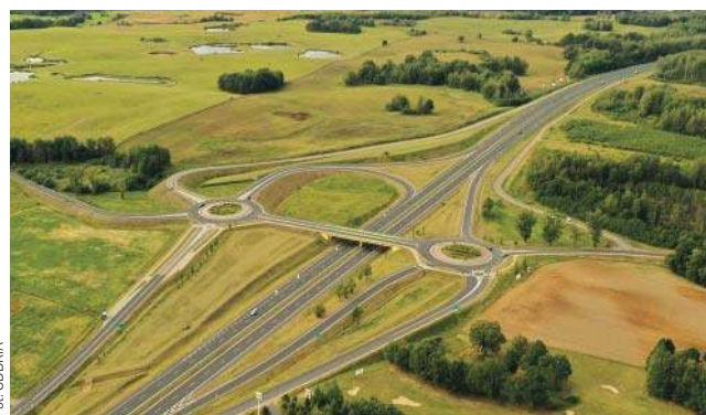
Budowa drogi S16 Mrągowo — Orzysz — Ełk
