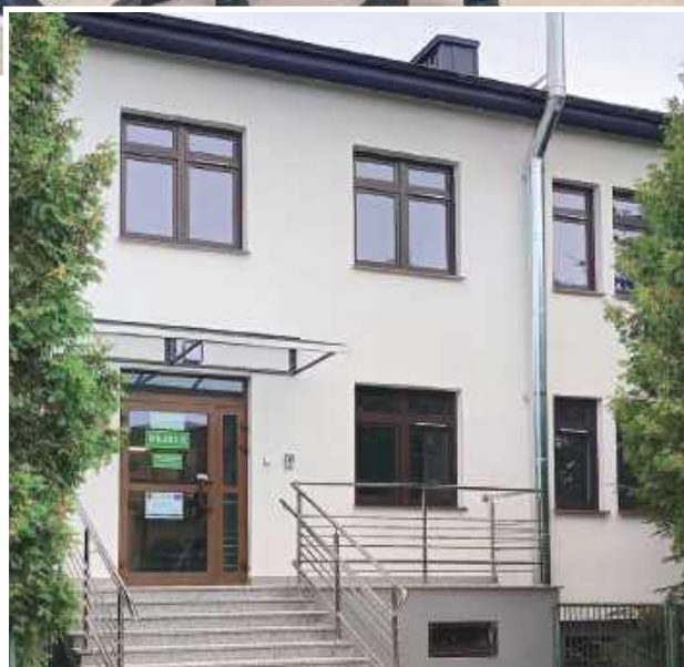
an Zakres prac objął zarówno roboty budowlane, jak i instalacyjne
