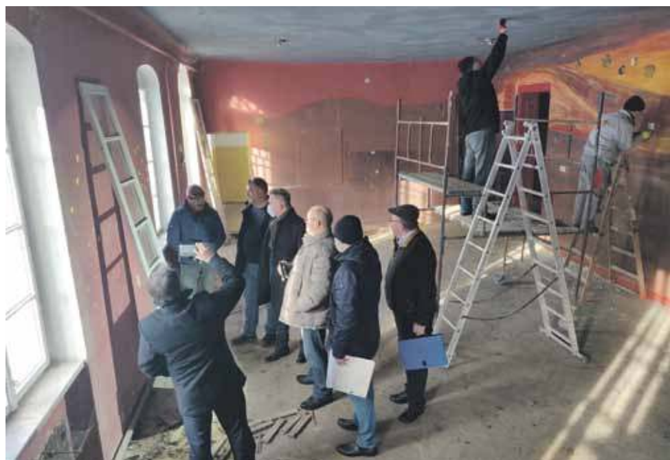
Na ścianach Dworu Berskich w Tylmanowej pod grubą warstwą tynku w wielu miejscach udało się odkryć ciekawą polichromię.
