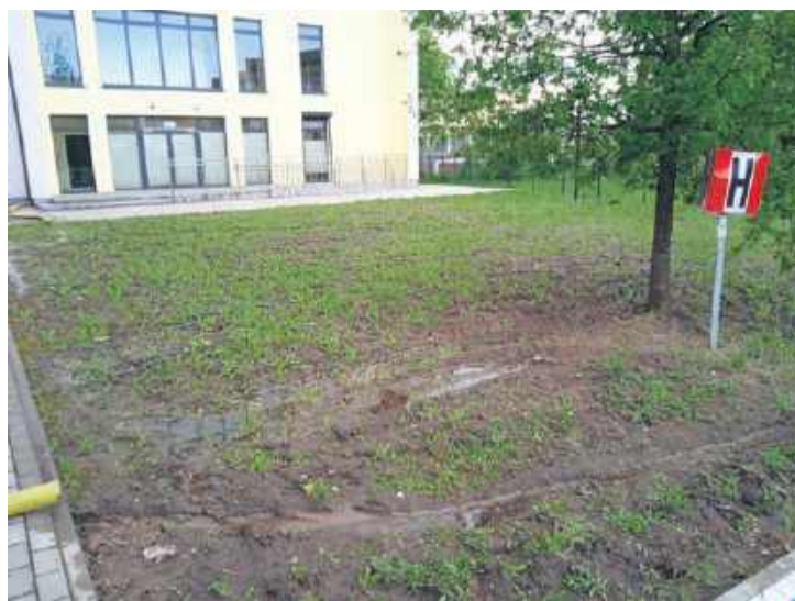
Teren przy PCPR, na którym zalegała woda po opadach deszczu. Fot. z archiwum ZSLiA
