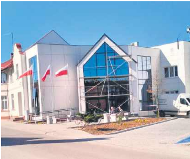
Przy Urzędzie Gminy w Śliwicach trwały prace związane z myciem okien i konserwacją wejścia. Fot. nadesłane
