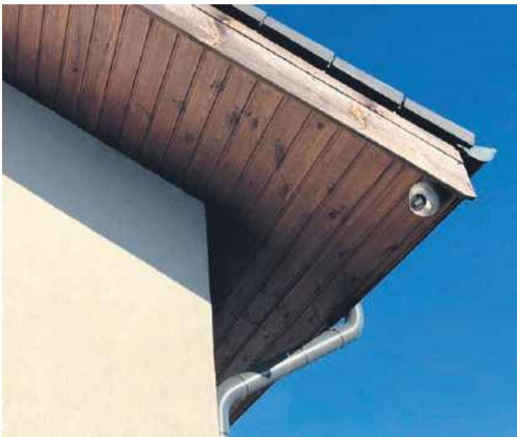
Miejsca montażu kamer na budynkach mieszkalnych są różne. Jednym z nich może być konstrukcja dachu.
