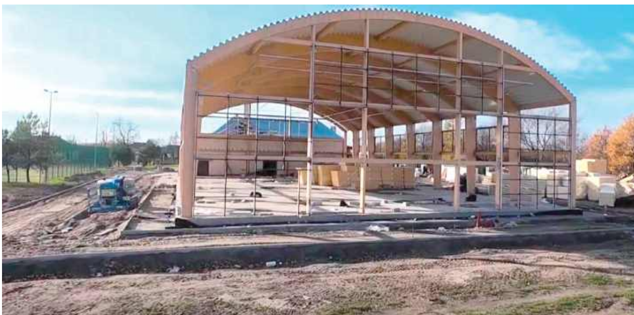
Powstała już konstrukcja dachu
