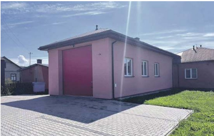
Rozbudowa strażnicy OSP w Drwałach
