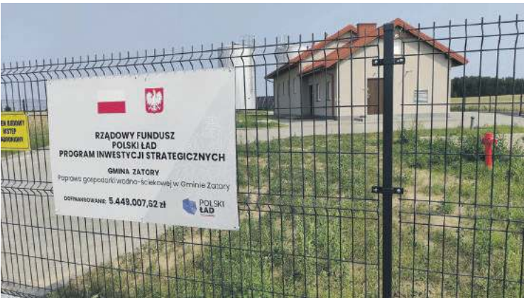
Stacja uzdatniania wody
