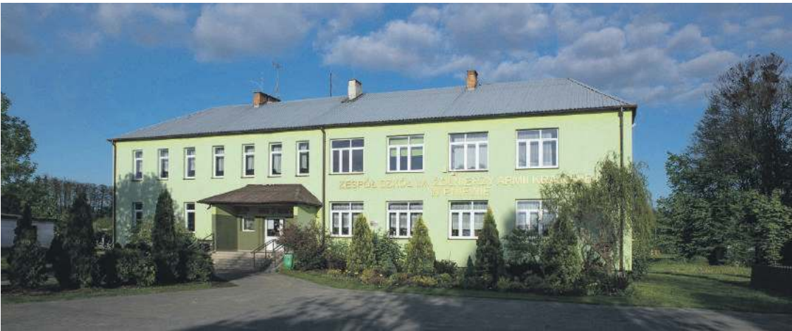
Termomodernizacja budynku szkoły w Pniewie
