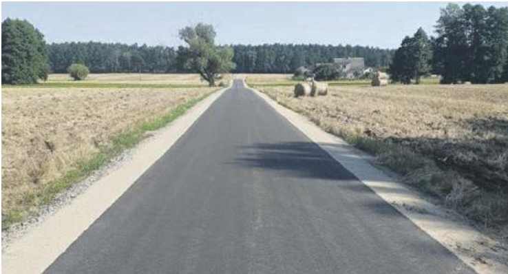
Przebudowa drogi w Drwałach – jednej z wielu zrealizowanych w tej kadencji
