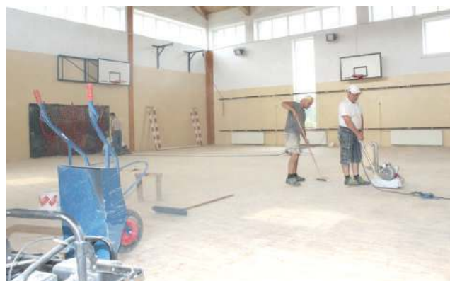
Wewnątrz sali gimnastycznej jeszcze trwają prace remontowe. Specjaliści odnawiają aktualnie parkiet, który jest cyklinowany, a następnie będzie polakierowany
