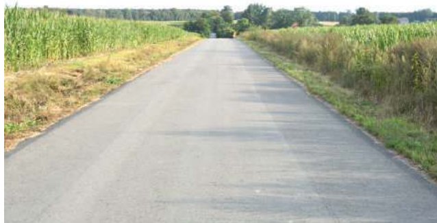
Mieszkańcy ul. Plebańskiej w lipcu 2017 r. doczekali się 350-metrowego fragmentu drogi asfaltowej. Wcześniej w tym miejscu znajdowała się droga polna
