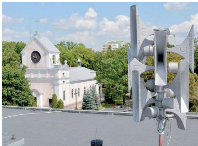
Na terenie miasta znajdują się 22 syreny, m.in. na urzędzie miasta, na budynku starostwa, na wieżowcach PSM, budynku OSP Włostowice, szkołach (KEN, SP4) na Przemysłowce czy przychodni na ul. Centralnej
