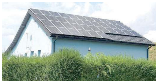
Na budynku w Górze Puławskiej została zamontowana instalacja fotowoltaiczna. Energia ze słońca zasili m.in. aparaturę sterującą uzdatnianiem wody
