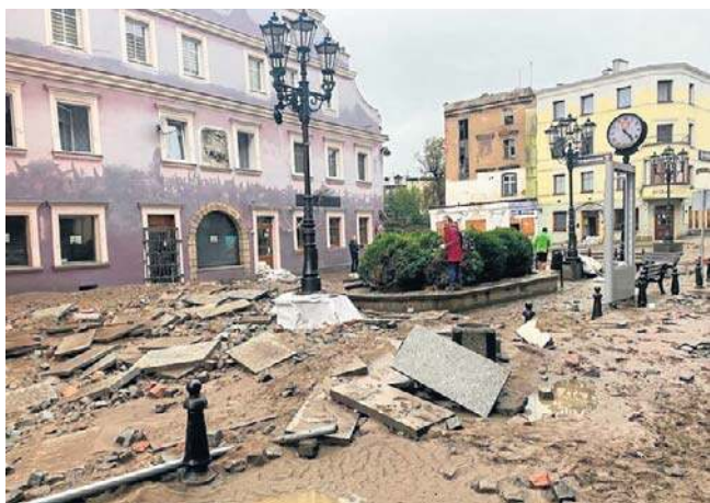
Zniszczenia w Kłodzku są gigantyczne. Ze wszystkich sklepów w mieście wykupiono zapasy wody pitnej
