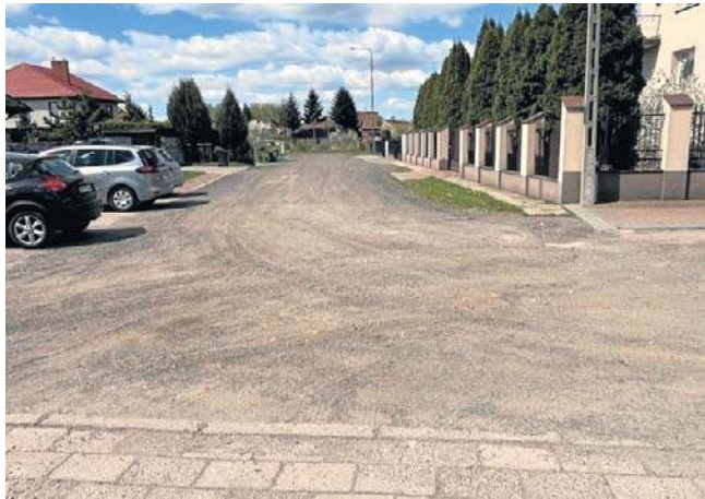
Odcinek ulicy Niemcewicza w Radomiu zostanie przebudowany.
