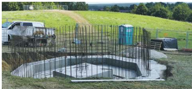
Na pierwszym planie budowa altany. Kilkadziesiąt metrów dalej będzie palenisko
