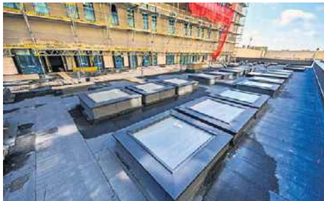
Prace na budowie wstrzymano w 2024 roku
