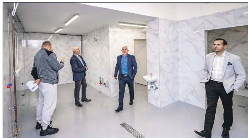
➤ Szkoła w Starym Pilczynie przeszła gruntowną metamorfozę, zyskując nowoczesne zaplecze kuchenne i odświeżoną stołówkę. Gmina Łaskarzew odebrała właśnie prace budowlane
