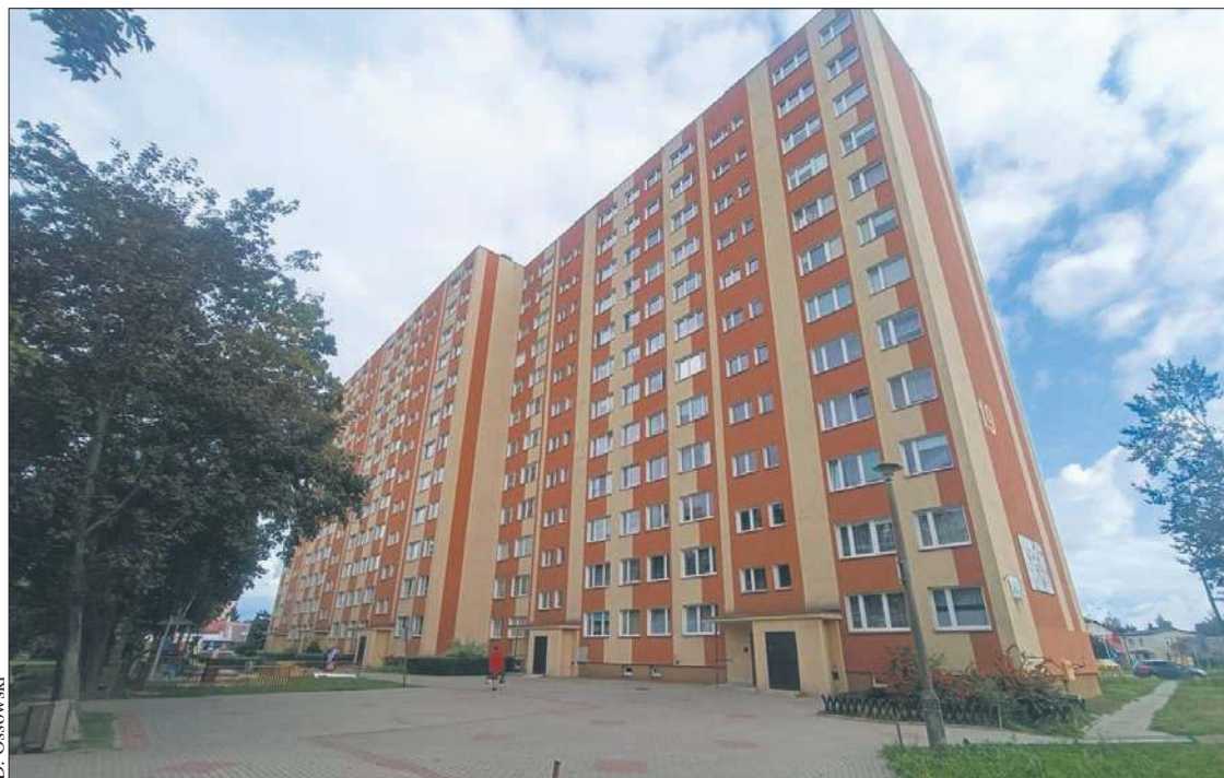
Blok przy ul. Mickiewicza 19
