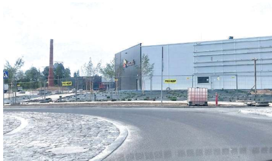
Trwają ostatnie prace przy Galerii Karuzela. Rondo przy centrum jest już dostępne dla kierowców
