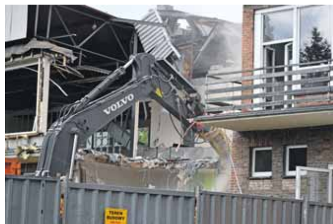
Duża inwestycja zaczyna się od demolki
