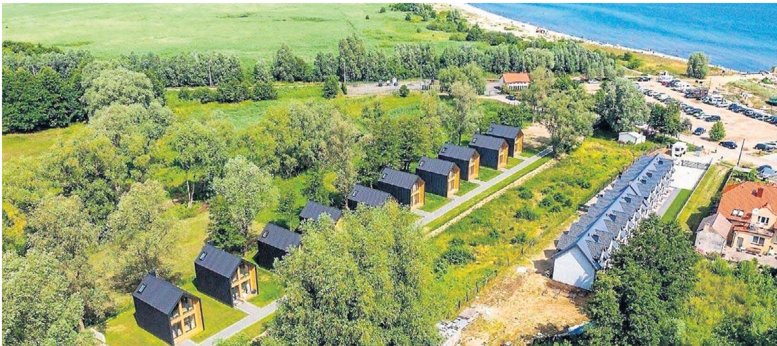
Domki covidowe w Mechelinkach to słynny przykład samowoli budowlanej. Zapadła decyzja o ich rozbiórce
