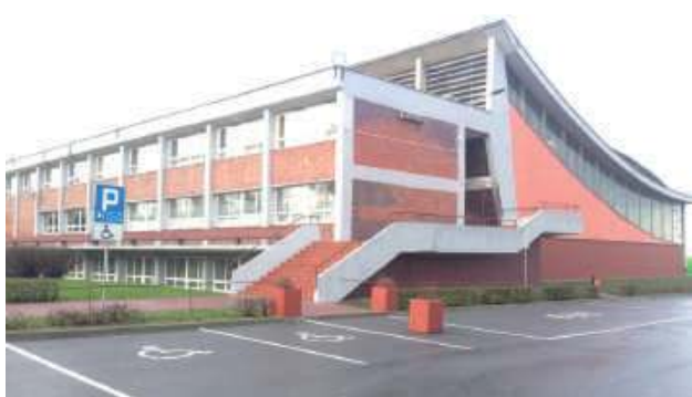
W obiekcie przy ul. Partyzantów oprócz hali znajduje się jeszcze kryty basen. Władze miasta nie mają wątpliwości co do konieczności przeprowadzenia generalnego remontu budynku, jednak podkreślają, że konieczna jest dokładna analiza stanu obiektu i kalkulacja kosztów
