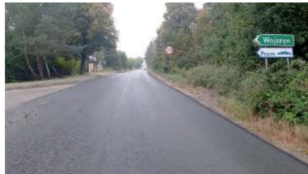
Już od dobrych kilku tygodni trwa przebudowa drogi prowadzonej do Janowic. Na chwilę obecną prace trwają w Oblasach
