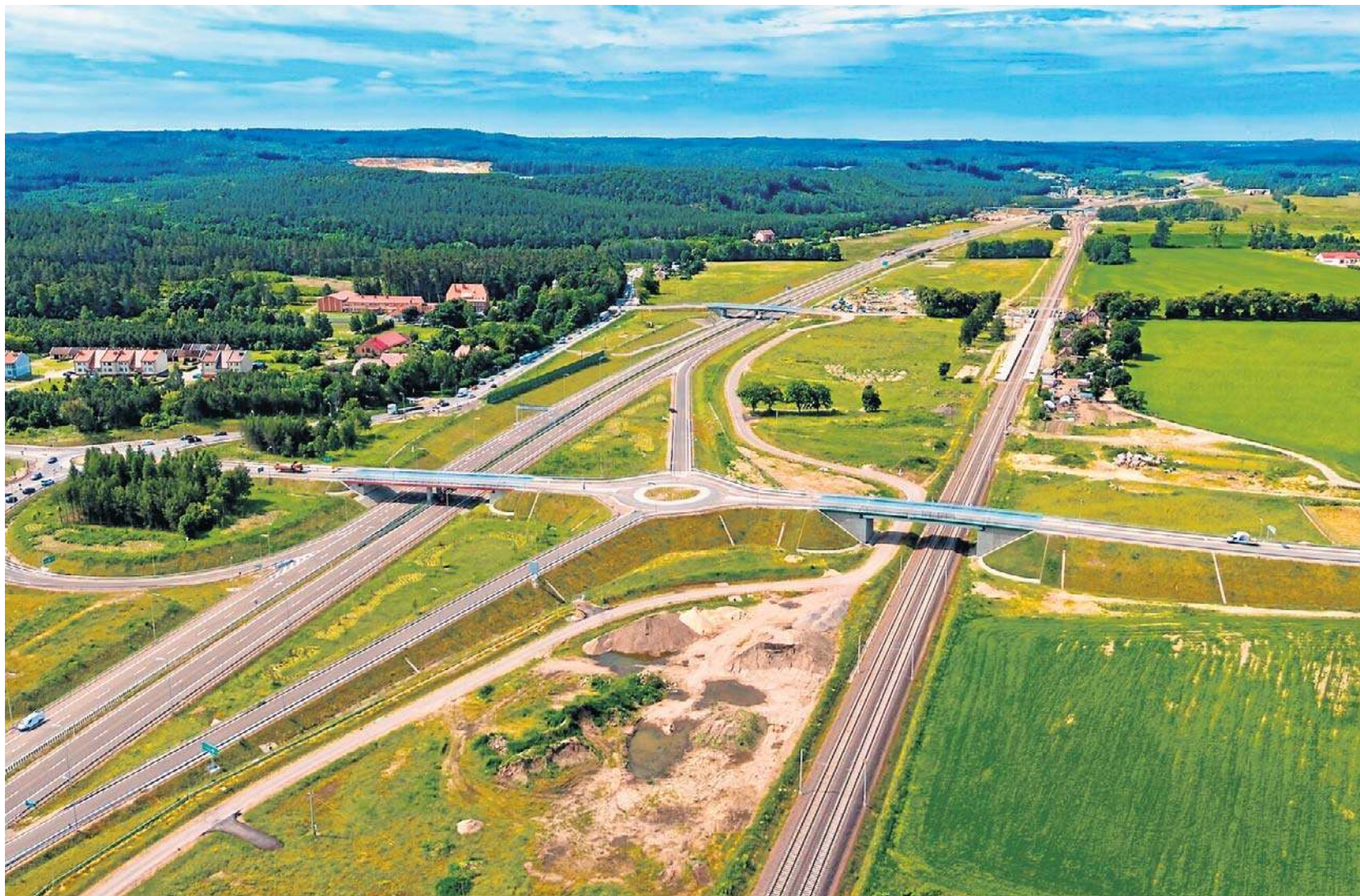
Zwieńczeniem prac było oddanie do użytku 40-kilometrowego, ostatniego brakującego fragmentu S6 z Leśnic do Słupska
