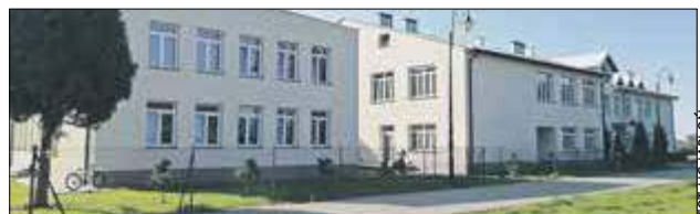
Prace adaptacyjne są już na finiszu
