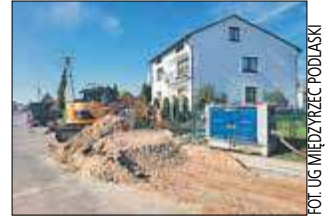
Rozpoczęła się budowa kanalizacji w Wysokim
