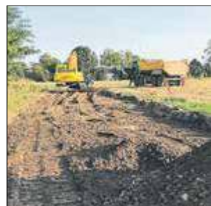
I etap prac polega na wykonaniu podbudowy z kruszywa łamanego
