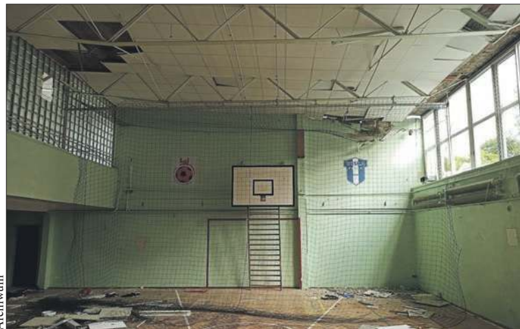
Zniszczona hala sportowa - obiekt dla eksploratorów
