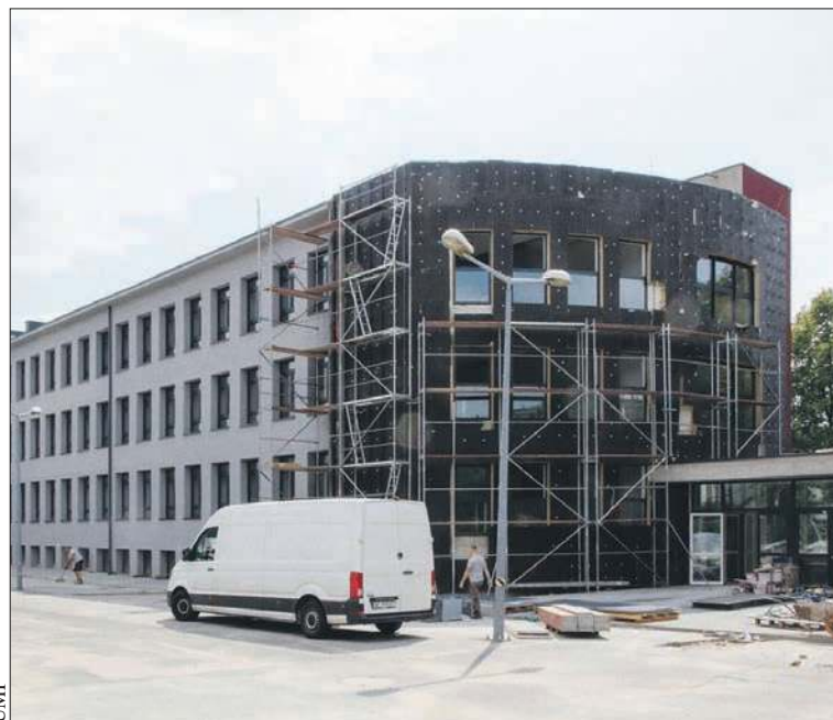
Wykonawca będzie miał trzy miesiące na realizację bieżni rekreacyjnej przy ZST
