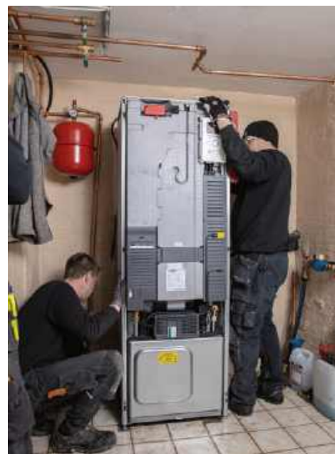
🔧 ...jak i modernizacja instalacji grzewczej. NIBE-BIAWAR
