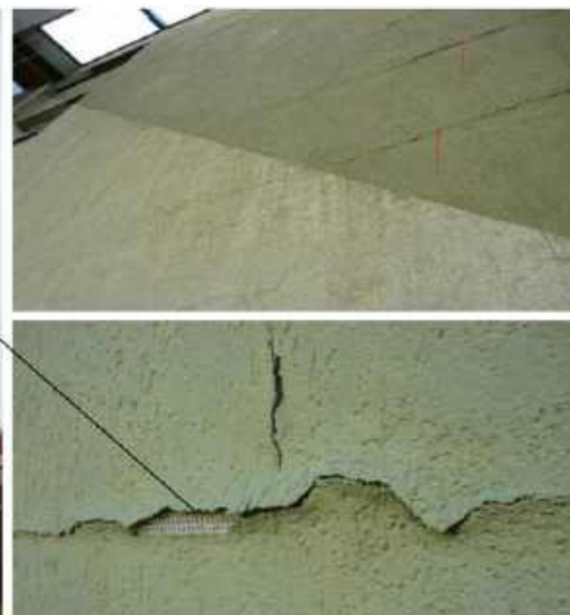
Spękania na łączeniach styropianu i wełny. P. Zemene, Czeskie Stowarzyszenie Producentów Styropianu
