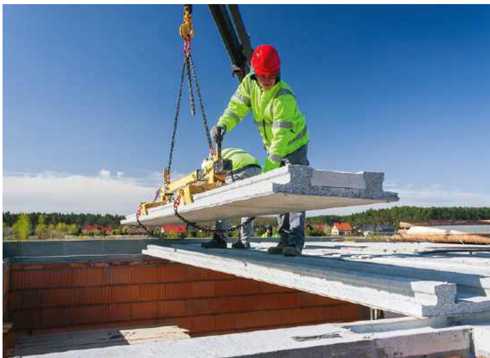
Budowa stropu panelowego realizowana jest przy użyciu lekkiego dźwigu HDS – takim sprzętem można wjechać niemal na każdą działkę. STROPY.PL
