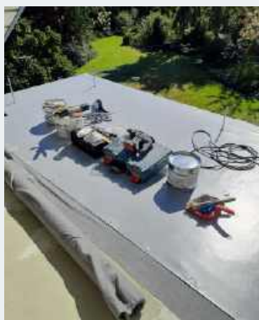
🔧 Naprawiono i wyrównano strop, osadzono w nim kotwy stalowe pod balustradę.
