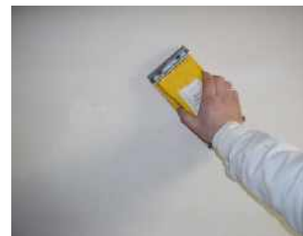
Suchą powierzchnię szlifuje się pacą z drobnym papierem ściernym.
