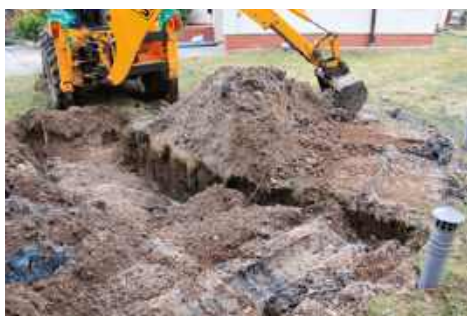
🔧 Remont дренаżu oznacza konieczność rozkopania ogródka. J. WERNER
