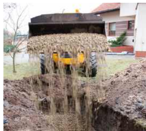
🔧 Pakiety drenażowe zastąpiono tradycyjnym rozwiązaniem, czyli kruszywem. J. WERNER
