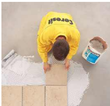
🔧 Montując płytki, klej należy nanosić na podłoże oraz na spodnią powierzchnię kafelków. Przyklejając nowe płytki do starych trzeba użyć elastycznej zaprawy przeznaczonej do trudnych powierzchni. CERESIT
