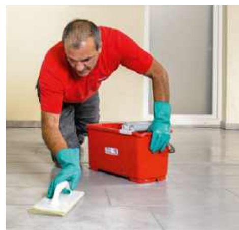
🔧 Zaprawę spoinującą aplikuje się w szczeliny między płytkami za pomocą pacy gumowej. Gdy masa wstępnie stwardnieje, jej nadmiar usuwa się wilgotną gąbką. SOPRO
