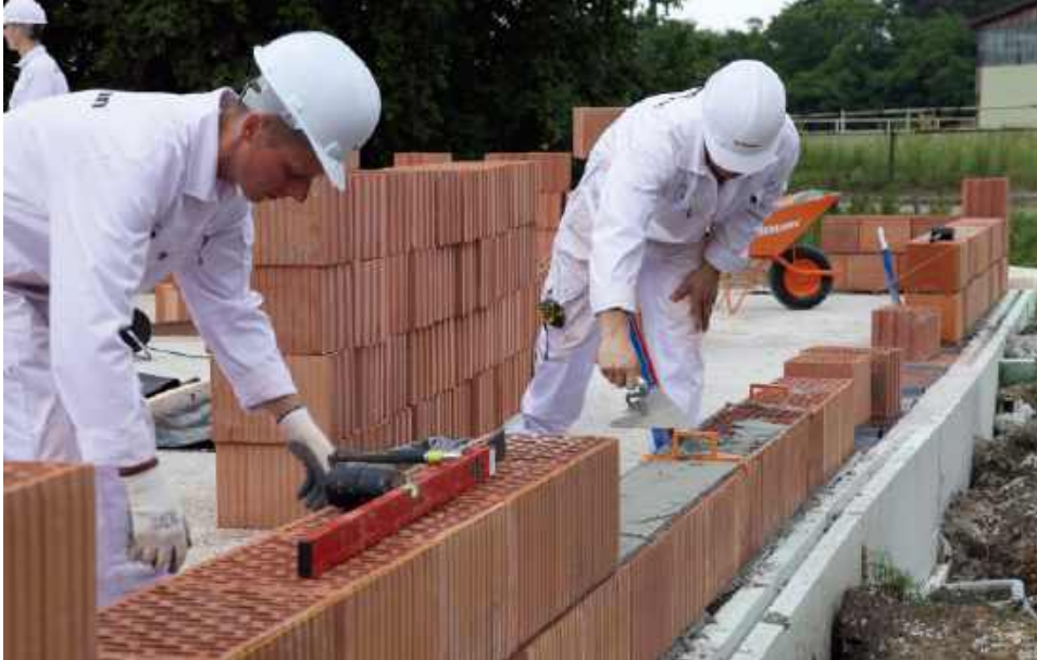
Do murowania ścian dwuwarstwowych stosuje się ceramikę poryzowaną o grubości od 18 do 25 cm. ZCB OWCZARY
