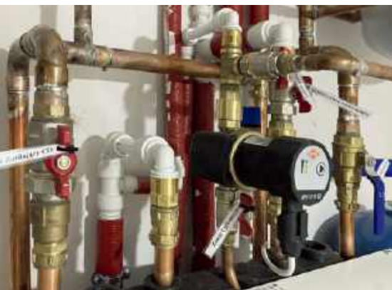
Przy wymianie rur i osprzętu ważne jest odpowiednie ich oznakowanie. RWC
