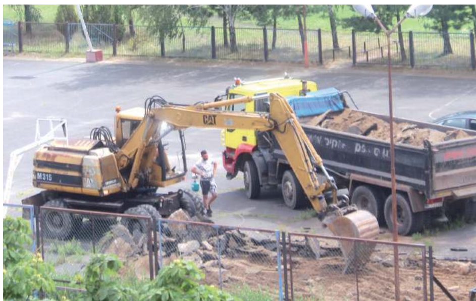
W lipcu przystąpiono do zerwania nawierzchni starego boiska do koszykówki na terenie kompleksu sportowego SP nr 6
