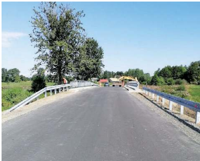
Przebudowa obiektu mostowego na rzece Szyszla.
