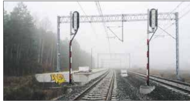
– Na przystanku Biała Podlaska Wschodnia wykonawca układa obecnie nowe rozjazdy i tory, które zapewnią sprawne przejazdy pociągów – informuje Karol Jakubowski z zespołu prasowego PKP PLK
