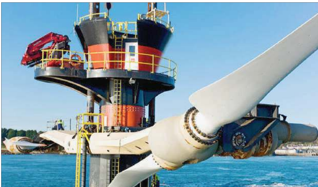
Pojedyncza wieża elektrowni pływowej z turbiną SeaGen firmy Siemens o mocy 1,2 MW
