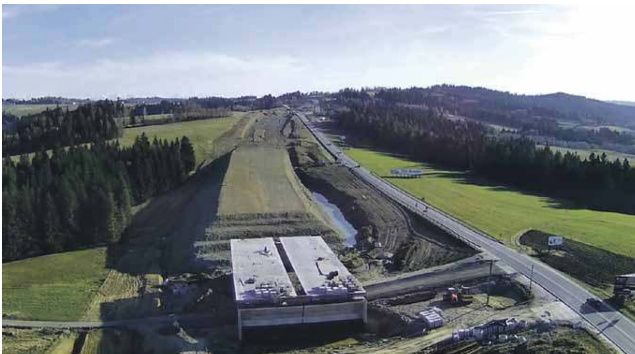
Budowa nowej zakopianki w Rdzawce
