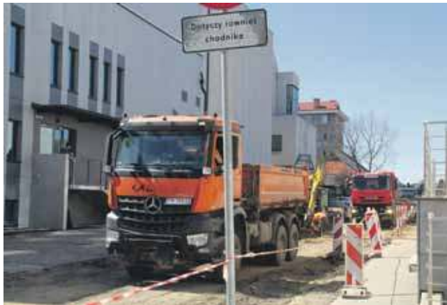
Rozpoczęła się przebudowa uliczki przy Miejskim Centrum Kultury.
