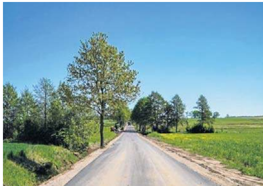
FOT. GMINA BARWICE
