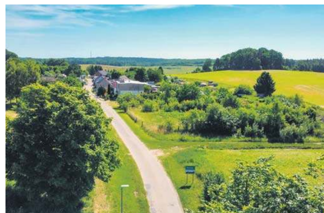
Przebudowa drogi do miejscowości Tarmno
