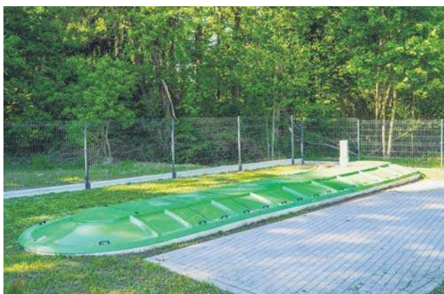
Budowa oczyszczalni ścieków w miejscowości Chwalimki
