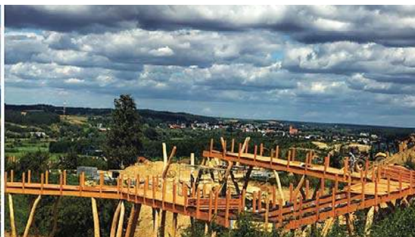
Wieża w Kurzętniku w budowie
