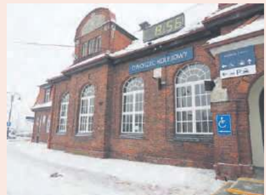
W poczekalni dworca, od frontu budynku, zamontowano nowe, stylizowane okna drewniane.
