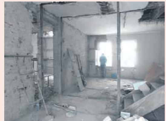
Na pierwszym piętrze budynku dworca rozpoczęły się prace budowlane.
