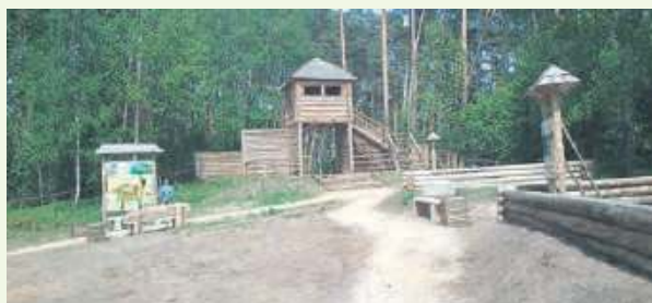
Rekonstrukcja średniowiecznego grodu – stan sprzed nawałnicy.
