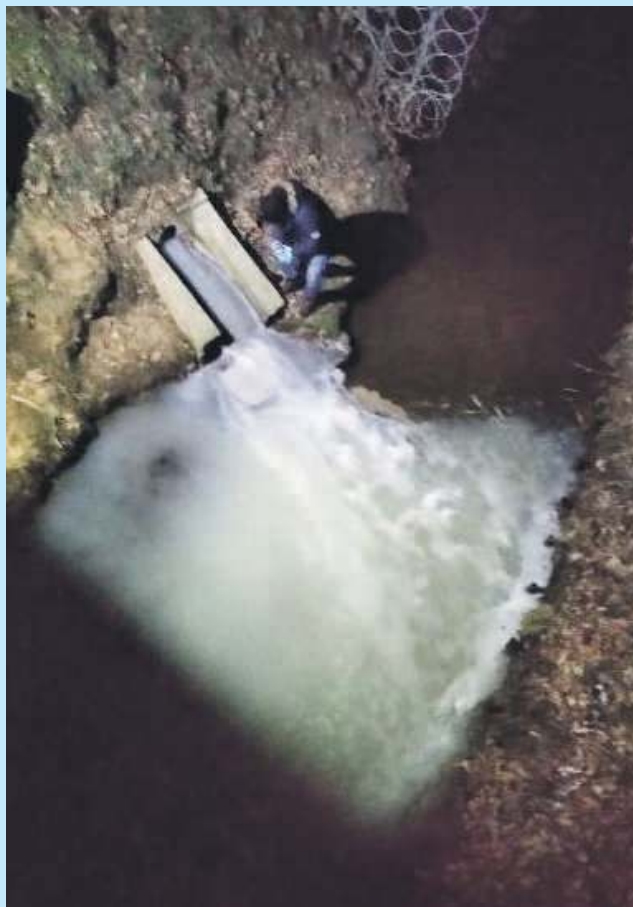
Spust ścieków do Odry
