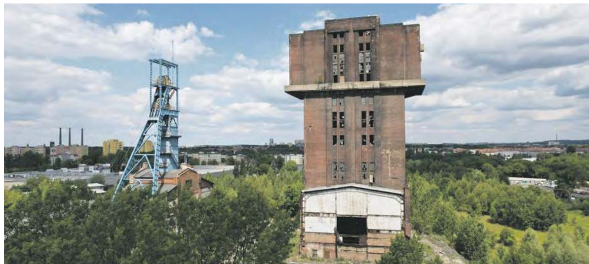
Szyb Krystyna to budowa przepięknej urody
