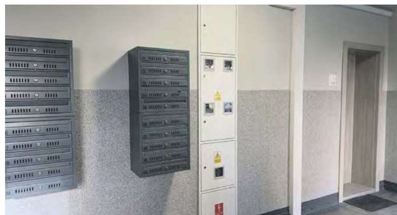
Klatki schodowe w budynkach BSM wyglądają doskonale
