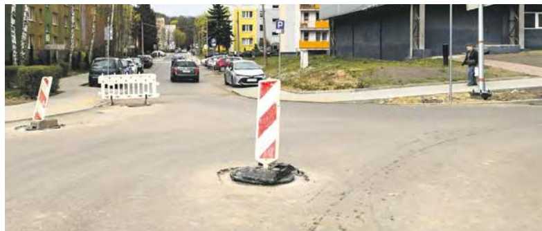
Koniec remontu ulicy Nickla coraz bliżej
