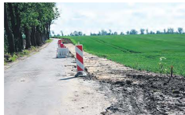
Na drodze powiatowej, na odcinku Raciąż – Piastoszyn prace związane z przebudową już się rozpoczęły.
